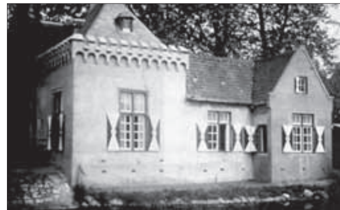
Het poortgebouw bij het kanaal rond 1910, gerenoveerd in neogotische stijl met kantelen en luiken in zandloper motief.
