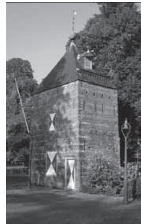
Dezelfde duiventoren anno 2008. In de twintiger jaren van de vorige eeuw werden de bijgebouwen afgebroken.
